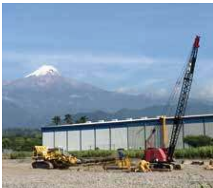
Tyasa公司Orizaba厂新建镀锌彩涂组合线项目的开挖工程
